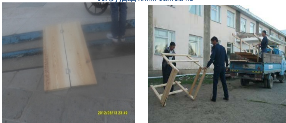
Зөөврийн налуу зам хийж байгаа нь
